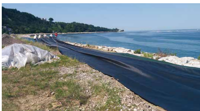
5. La stesa del geotessile Harpotex
