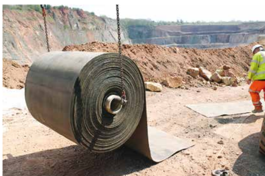
3. La movimentazione in cantiere del Concrete Canvas
