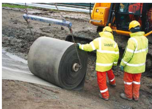
2. Il Concrete Canvas posato su superfici inclinate
