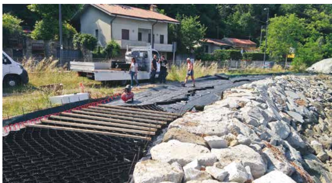
7A e 7B. La stabilizzazione meccanica attuata da Harpo
