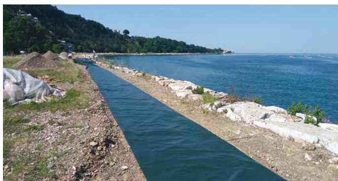
4. La stesa della geomembrana Harpocover
