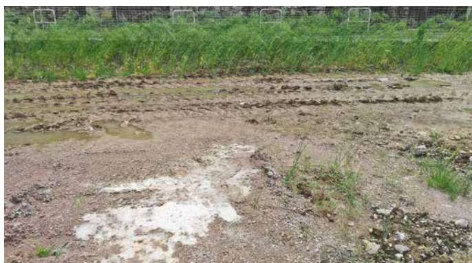
1. Il sottofondo da stabilizzare
