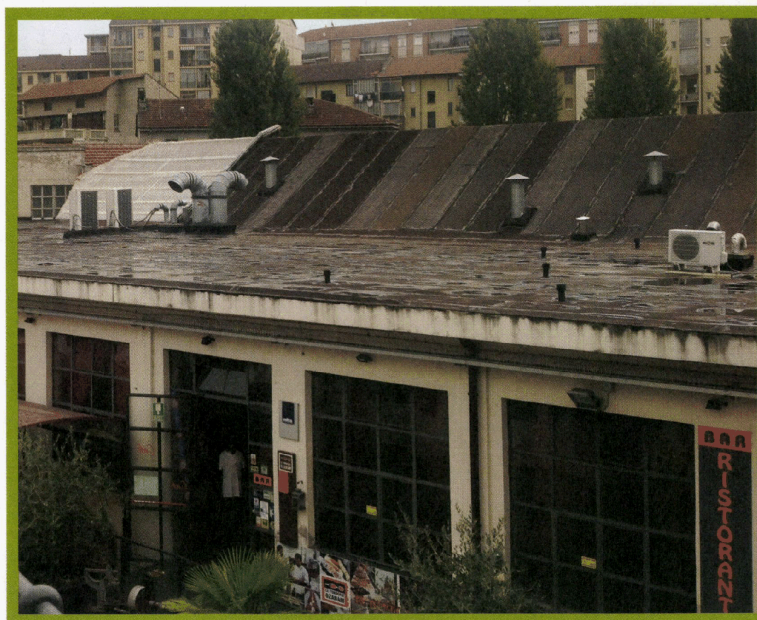
Nella foto principale, il "nuovo tetto" con orto di Casa Ozanam, così come si presenterà una volta che saranno conclusi i lavori.
