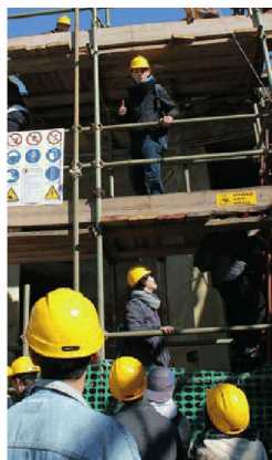
I ragazzi dell'istituto "Buniva" in sopralluogo sul cantiere Orti Alti.
