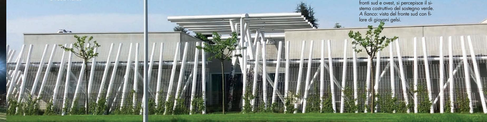
Sopra: dalle cortine dischiuse dei fronti sud e ovest, si percepisce il sistema costruttivo del sostegno verde. A fianco: vista del fronte sud con filare di giovani gelsi.
