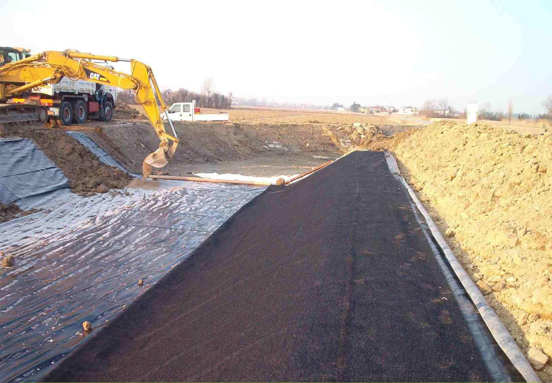
Posa del terreno di ricoprimento sulle scarpate (1/2)
