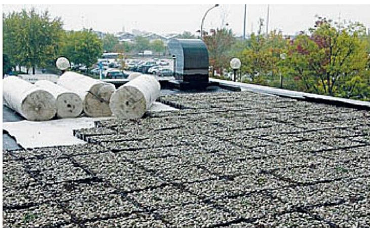
Il “tetto verde” della sede di Agraria dell'Università di Bologna, recente realizzazione./ METRO
