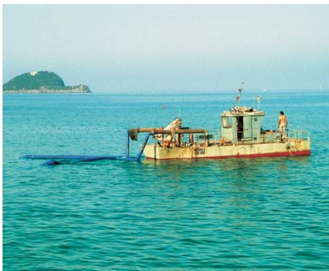
Operazione di riempimento con sorbona
