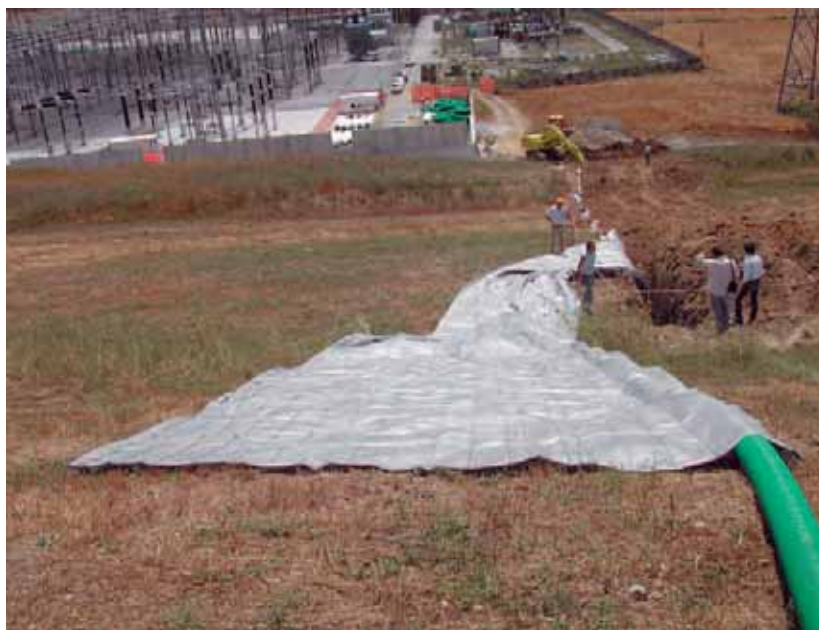
Fasi di posa
