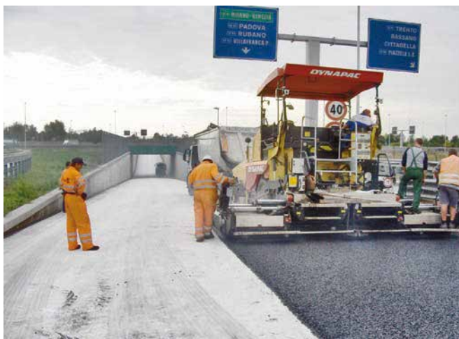
Ricoprimento con conglomerato bituminoso
