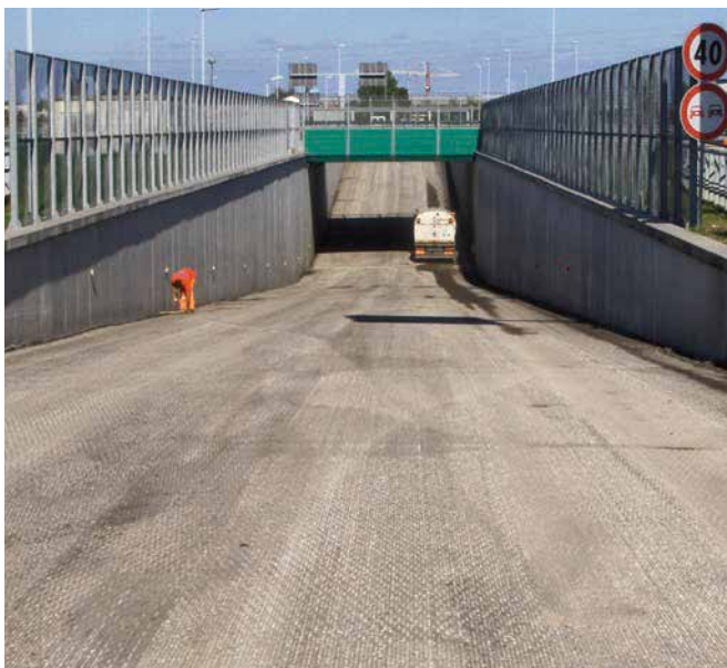
La superficie scarificata
