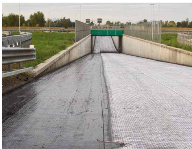
Stesa della mano di attacco sopra il geocomposito
