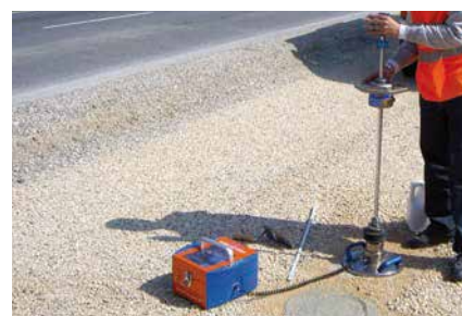
Le prove con piastra dinamica sulla fondazione rinforzata
