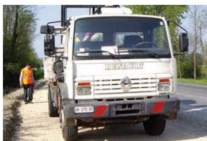
Il sistema Neoweb® Neoloy installato ed immediatamente transitabile
