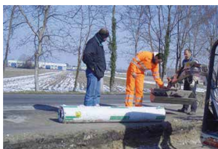
Piano di posa della fondazione stradale
