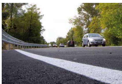
Il cantiere finito e aperto al traffico
