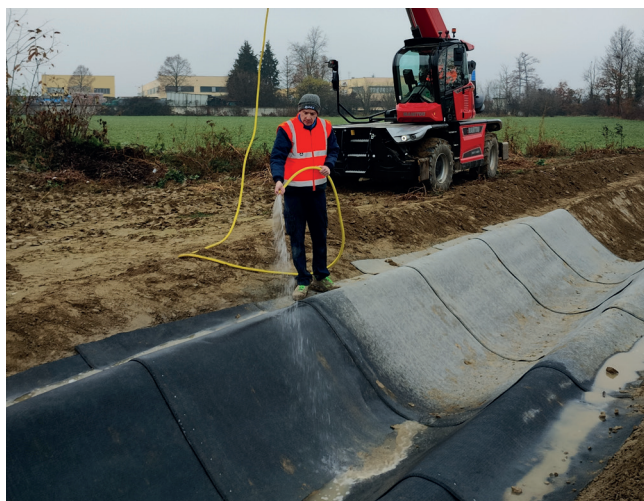
Trasporto agevole di Concrete Canvas® in rotoli, applicazione (qui a sinistra) e fase finale di idratazione (sopra)
