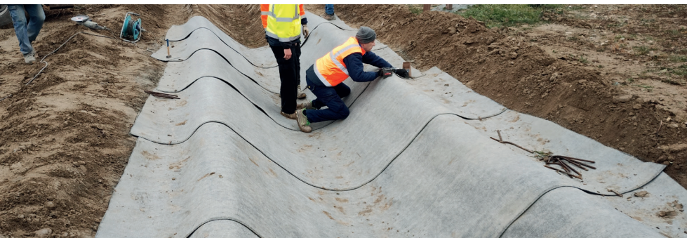
Trasporto agevole di Concrete Canvas® in rotoli, applicazione (qui a sinistra) e fase finale di idratazione (sopra)
