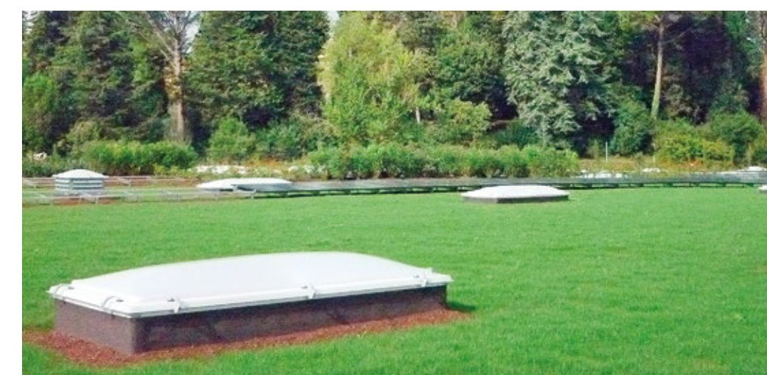
Qui sopra, un'immagine dei pannelli fotovoltaici installati sul tetto verde di Esselunga.
