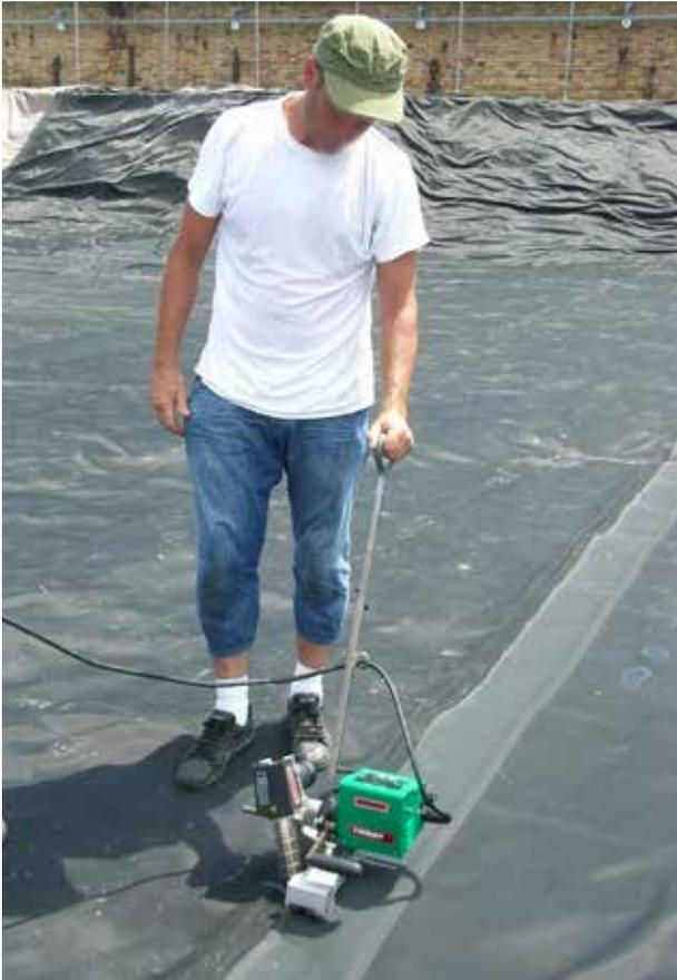
La geomembrana **Harpo WB** viene consegnata in cantiere in pannelli dotati di schema di posizionamento per l'apertura. Nel caso di installazione di più pannelli, questi dovranno essere disposti in modo da evitare giunzioni ad incrocio (ovvero 4 teli che si incontrano in un unico punto). Le giunzioni dovranno essere parallele alla pendenza delle sponde del bacino. I pannelli saranno posizionati con una estremità nella trincea di ancoraggio e saranno giuntati tra loro.
