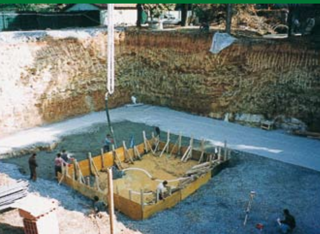
Costruzioni in edilizia (Turchia)
