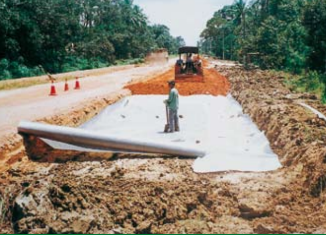
Costruzione di una nuova strada (Malesia)
