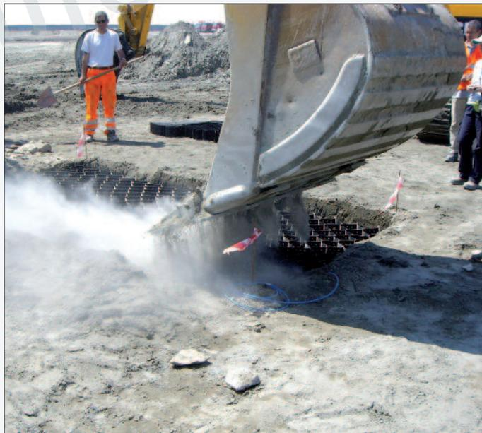
Figura 6 - Il riempimento del sistema in neoloy con il materiale di dragaggio
