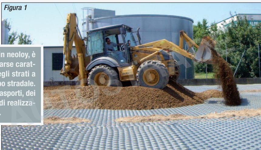
Applicando la tecnica del confinamento laterale in neoloy, è possibile reimpiegare i terreni di sottofondo, a scarse caratteristiche geomeccaniche, nella realizzazione degli strati a maggior rigidità in una sovrastruttura e nel corpo stradale. Ciò a beneficio dell'ambiente, con riduzione dei trasporti, dei macchinari impiegati nelle lavorazioni, dei tempi di realizzazione e della quantità di CO<sub>2</sub> emessa in atmosfera.
