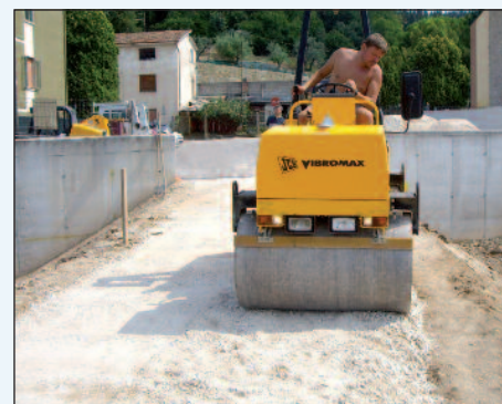
Figura 5 - La compattazione
