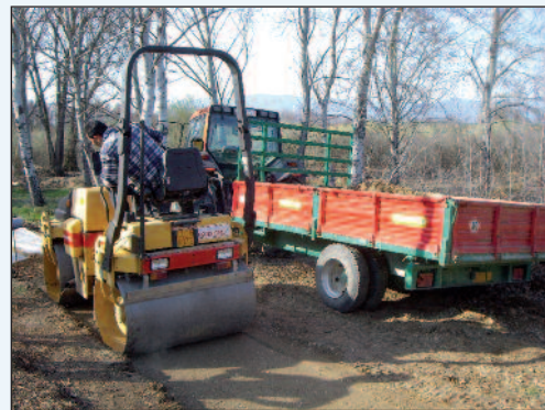
Figura 12 - La compattazione
