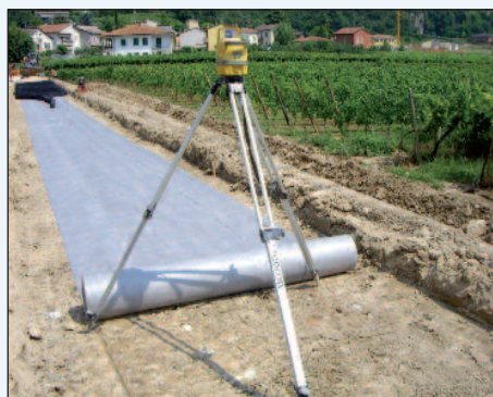
Figura 3 - La stesa del filtro separatore
