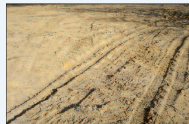
Figura 10 - Il sottofondo prima dell'intervento
