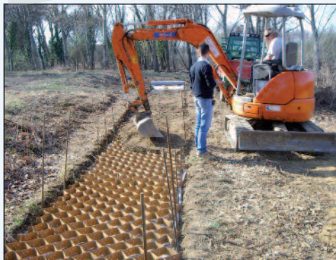
Figura 11 - La fase di riempimento
