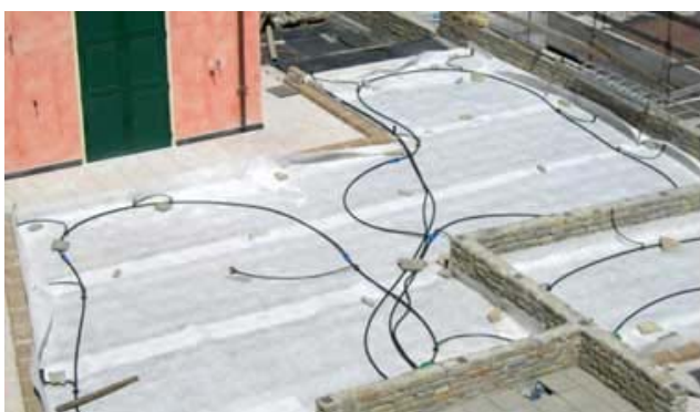
Impermeabilizzazione di tutta la superficie con HarpoPlan ZD UV
