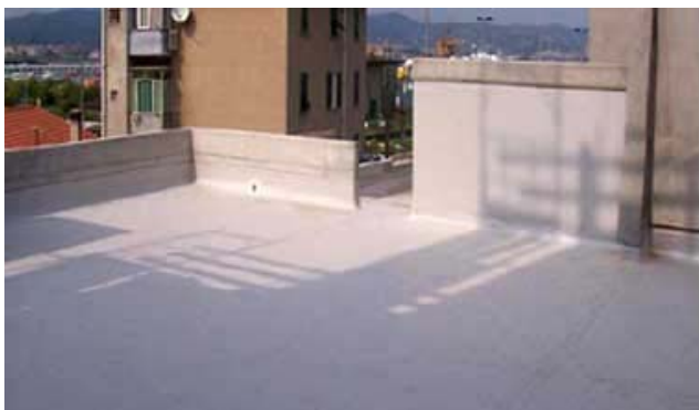
Impermeabilizzazione di tutta la superficie con HarpoPlan ZD UV
