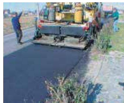
Stesa del conglomerato bituminoso
