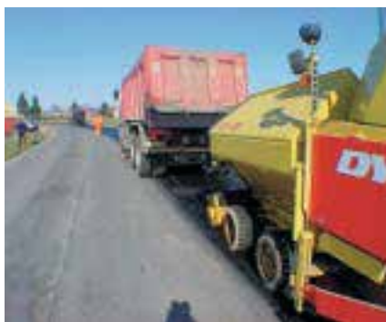
Operazione di rifornimento della finitrice
