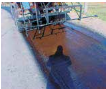
Diffusione dell'emulsione bituminosa
