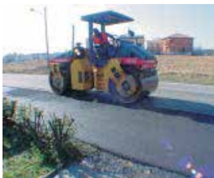
Operazione di compattazione
