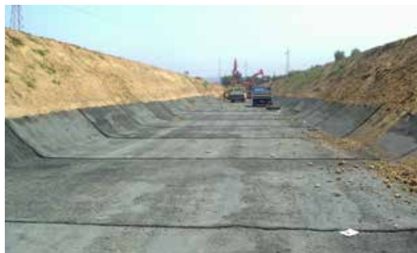
Posa dell' Enkamat® A20 (preintasato) sul fondo
