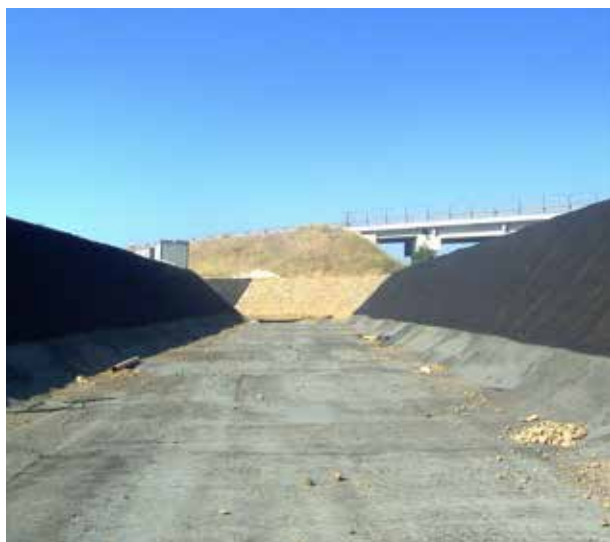
Posa dell' Enkamat® 7220 lungo le scarpate
