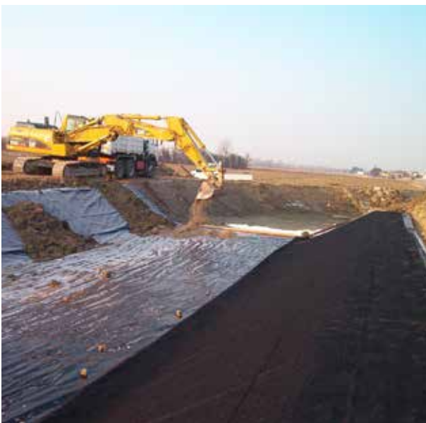
Canale di bonifica Posa dell' Enkagrip ® 7010W
