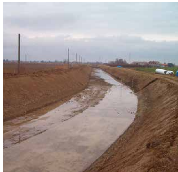
Canale di bonifica Ricoprimento con terreno
