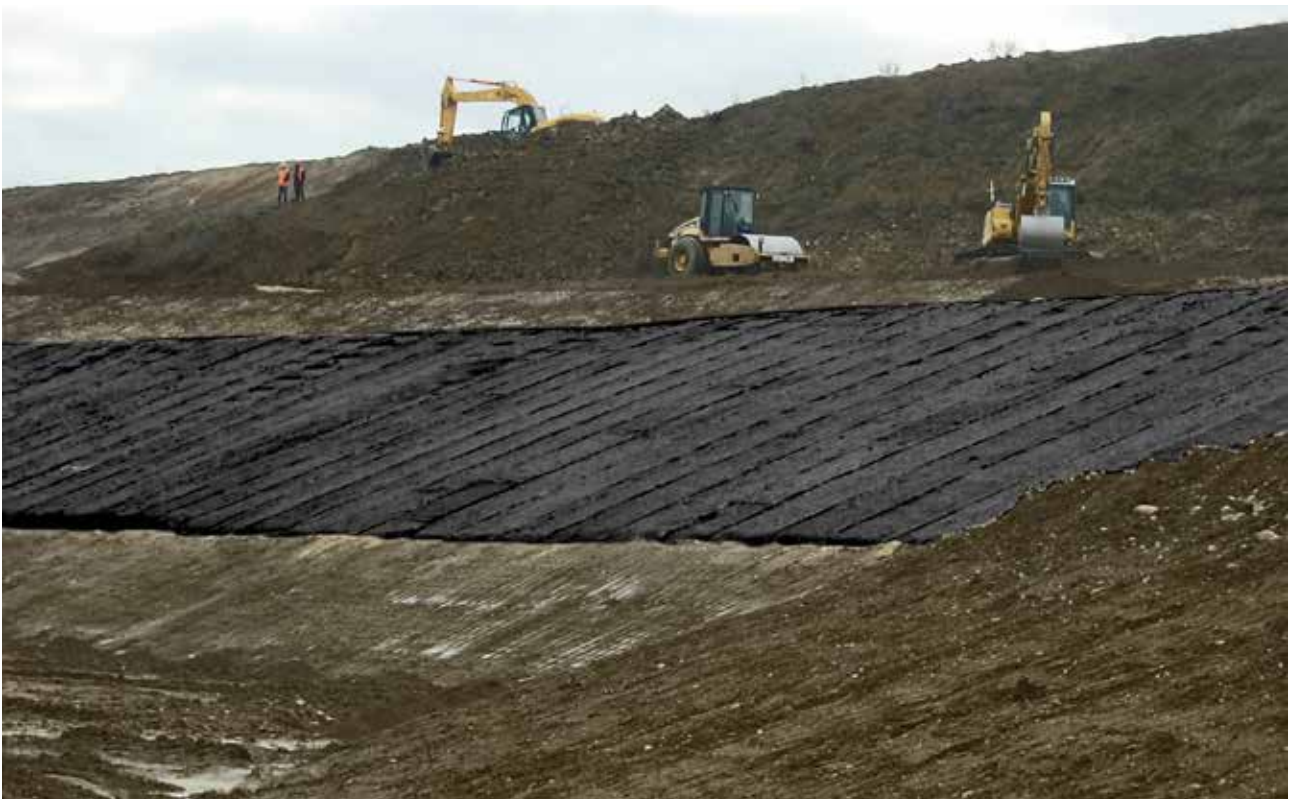
Posa dell' Enkamat ® 7020 su pendio
