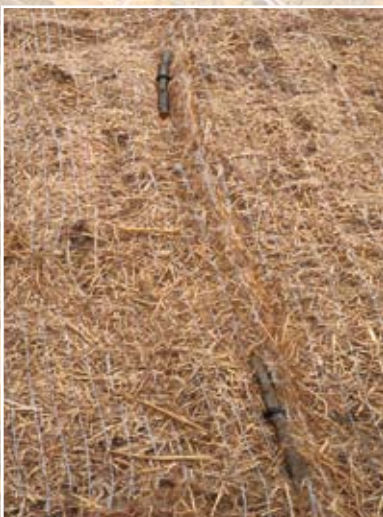
Particolare dei picchetti di fissaggio
